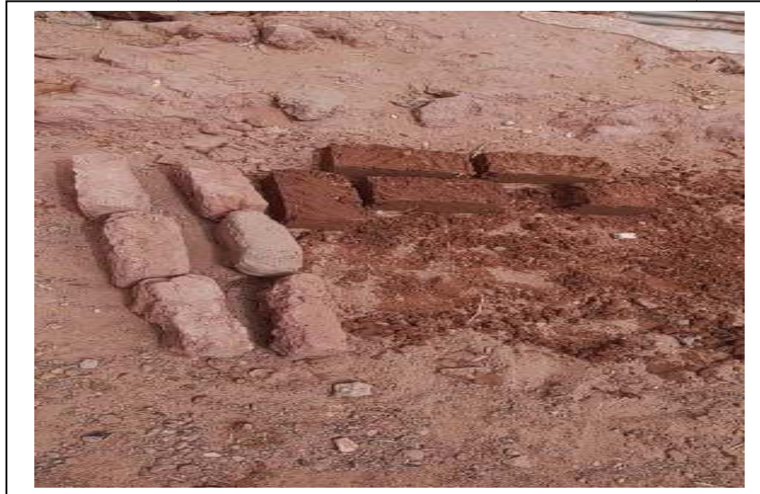
Figure 3-5 séchage de l'adobe
