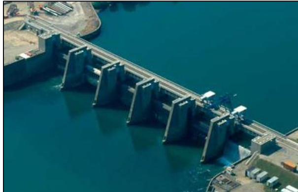
Figure 15 : énergie hydraulique Source : www.energiesrenouvelables.org
