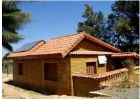
Il s'agit d'un F3, qui a été construit sur une surface de 84 m<sup>2</sup> en brique de terre argile, qui est un matériau peu conducteur de chaleur. Un programme de 600 logements sera prochainement lancé également avec ces techniques qui nécessitent un investissement additionnel entre 10 et 15%.
