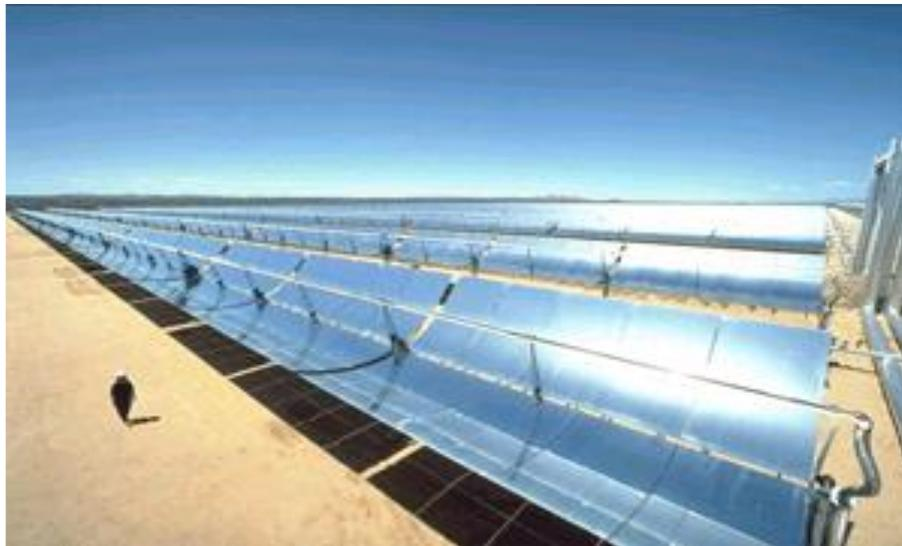
Figure I. 17: Collecteur cylindro-parabolique (SEGS).
