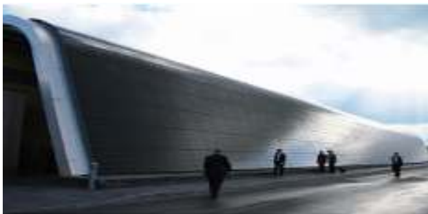
Figure I.11: Façade en CIGS au Pays de Galles, efficacité de 8,5% [8].
