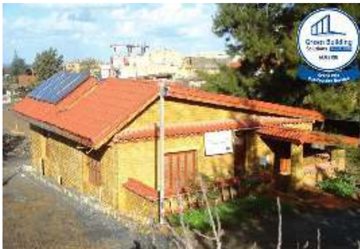
Figure 3.5 Vue externe de la maison
