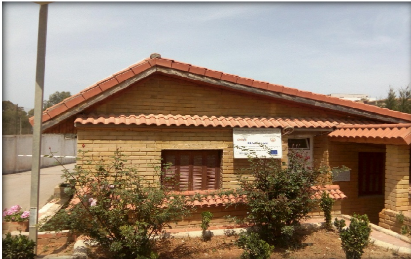
Figure 3.7 Vue de façade de la maison
