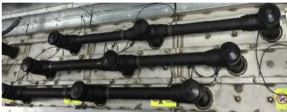
Figure II.10: Jeu de barre fermé avec haut niveau de sécurité et efficacité
