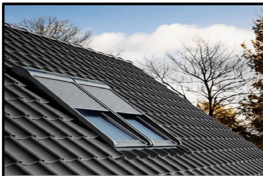
Figure 1.12 : volet fenêtre de toit roulant à énergie solaire.
