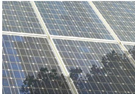
Figure I.5 - Panneau solaire ombragé par un arbre
