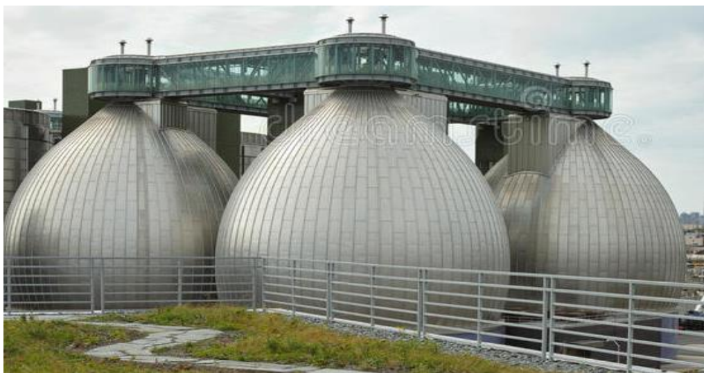
Figure I.5 : Un digesteur ovoïde construit en inox.
