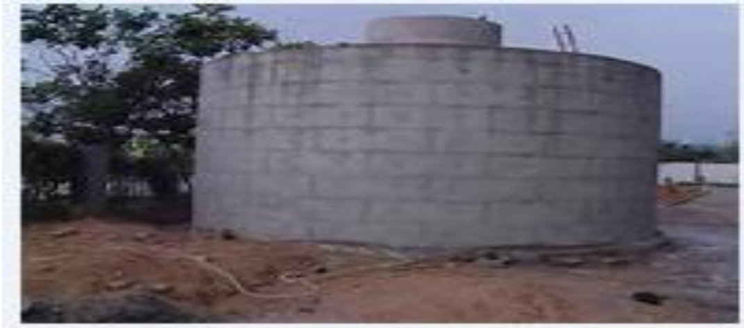
Figure I.4 : Un digesteur cylindrique en béton.
