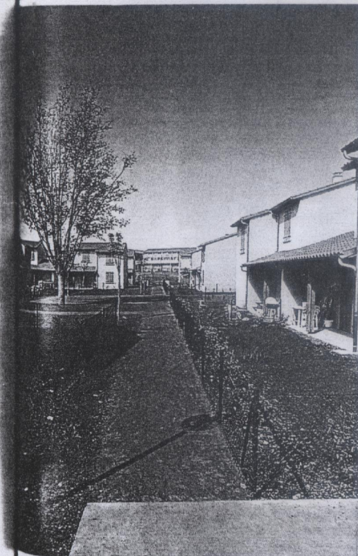
Les Jardins de Rabaudy à Castenet-Tolosan (photo à gauche). SA d'HLM "La Cité Jardin". Les 50 logements individuels locatifs utilisent les composants de base issus des ressources locales et des produits renouvelables comme le bois. Outre l'aspect mise en œuvre, entretien et durabilité, c'est leur faculté de recyclage et de moindre pollution tout au long de leur cycle de vie qui a été prise en compte ainsi que leur coût.
