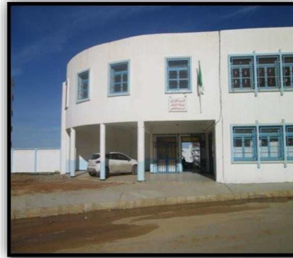
Figure 33: vue sur l'école
