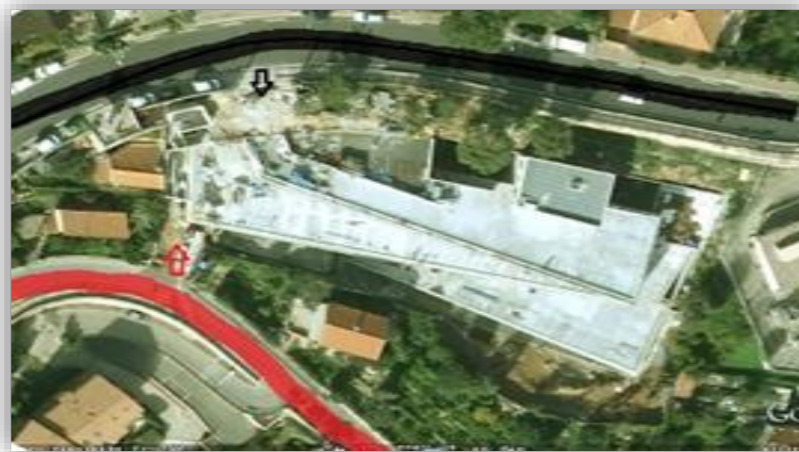
Figure 20: vue aérienne du projet
