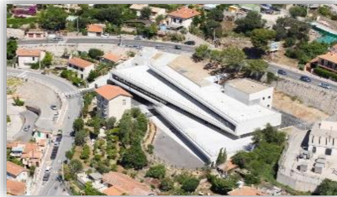
Figure 25: vue aérienne du projet
