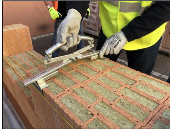
Figure 97: Briques monomur avec isolation intégrée
