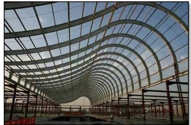
Figure 96: La charpente métallique.
