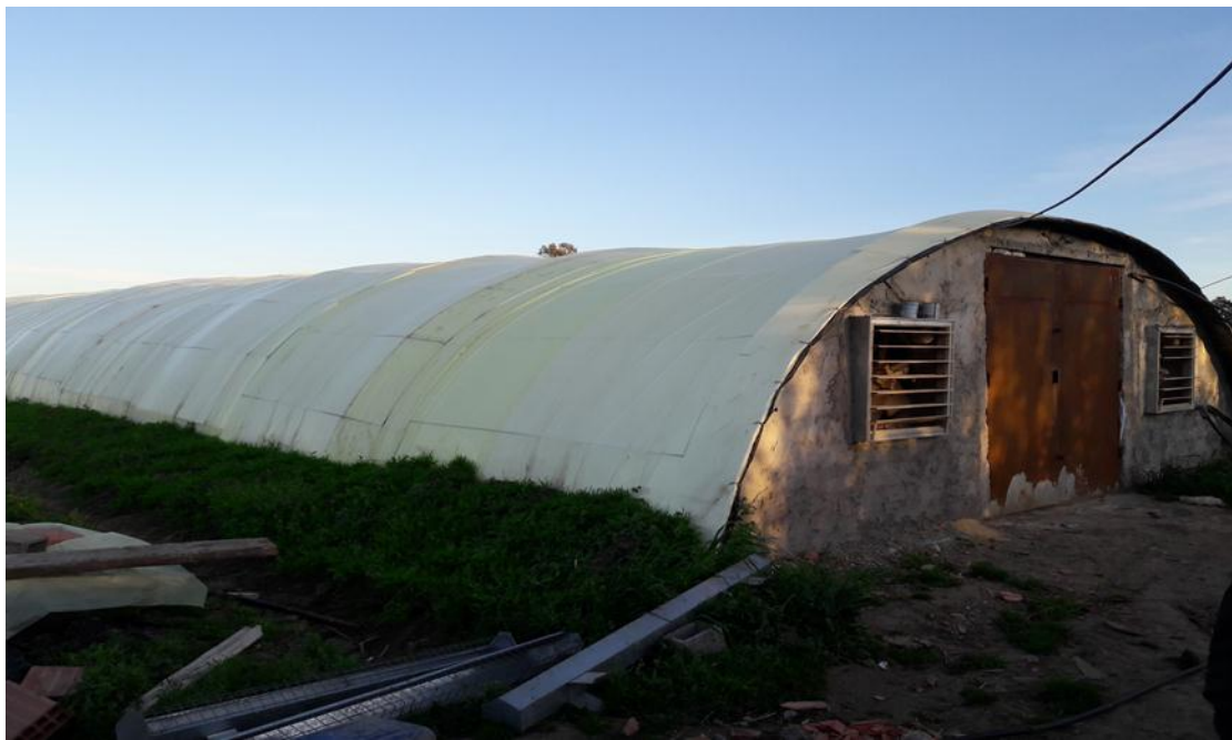
Figure 2:vue extérieur du bâtiment d'élevage
