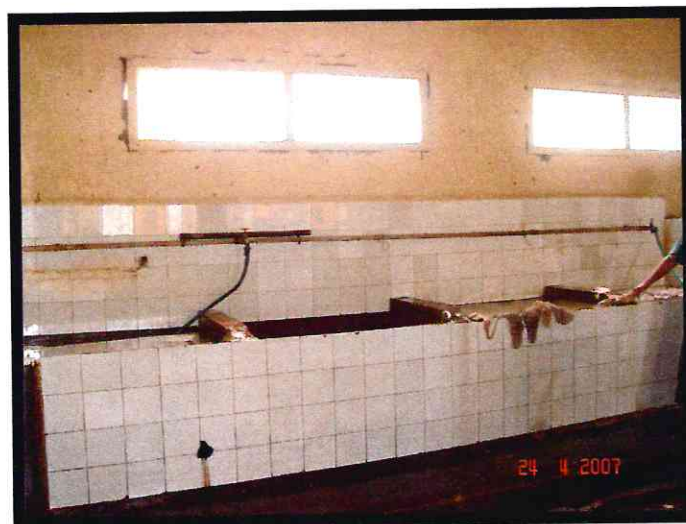
Photo n°22 : Salle de lavage
