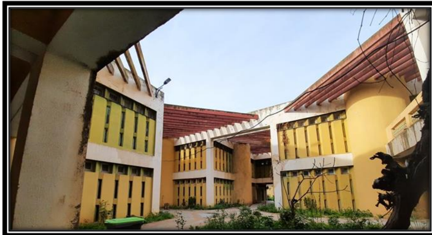
Figure 17: Bâtiment principal du département d'agronomie de l'université Saad Dahleb ; source : auteurs
