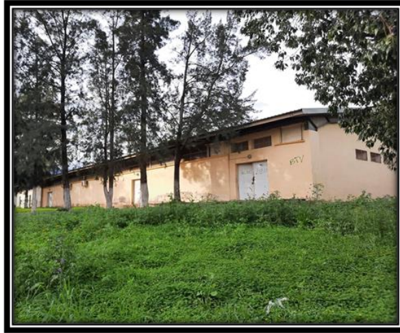
Figure 20 : Deuxième bâtiment du département ; source : auteurs.
