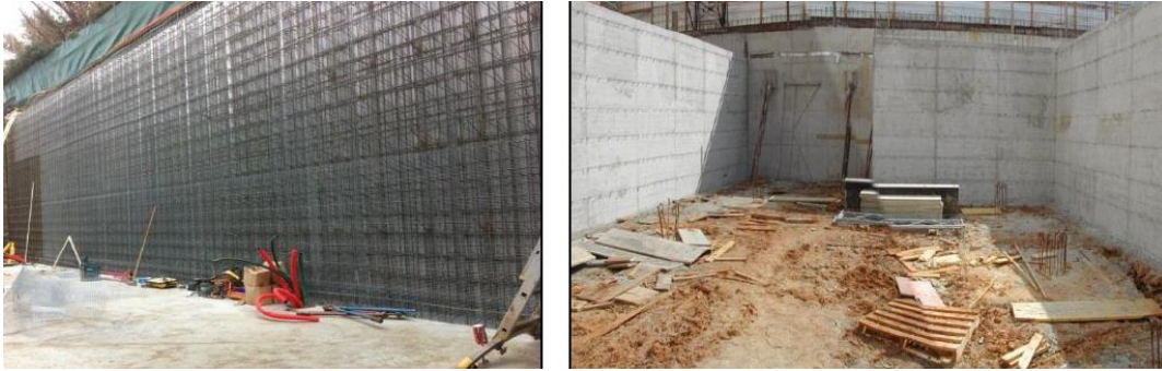
Figure 46 : mur de soutènement / Source : google image
