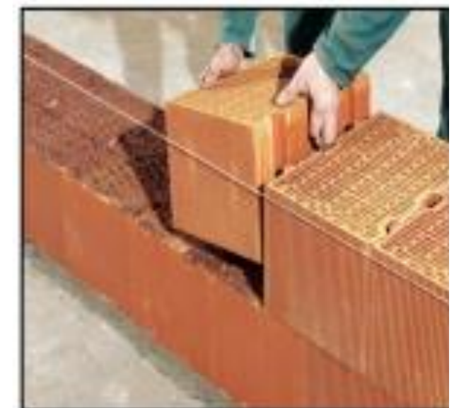
Fig 7.19: mise en œuvre la brique monomur Source : travaux.com
