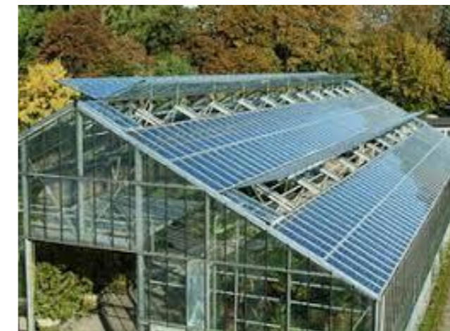
Serre agricole photovoltaïque Source : https://www.agriexpo.onlin
