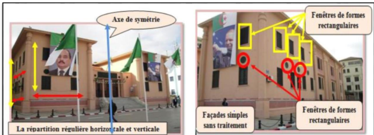
FIGURE II.39 : FAÇADE DU MUSEE
