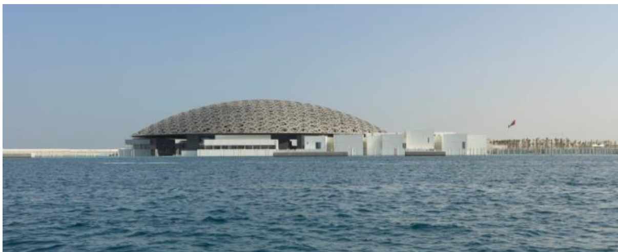
FIGURE II 53 : FAÇADE DU MUSEE
