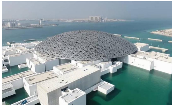
FIGURE II 68 : DOME EN ACIER
