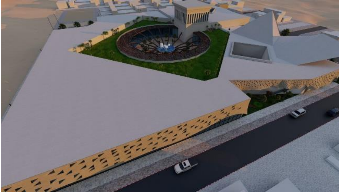
FIGURE III 34: VUE SUR L'ENSEMBLE DU PROJET
