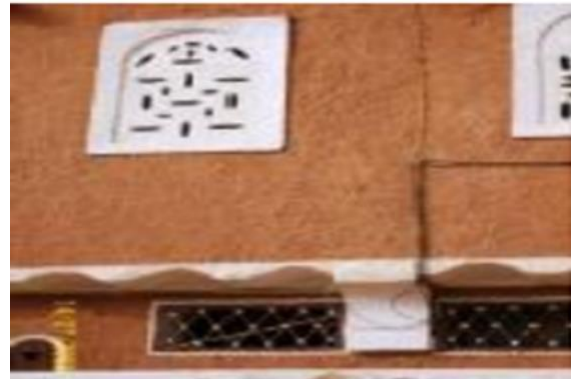
FIGURE 24 : ZOOM SUR LES FENETRES PROTECTION SOLAIRE DES FENETRES
