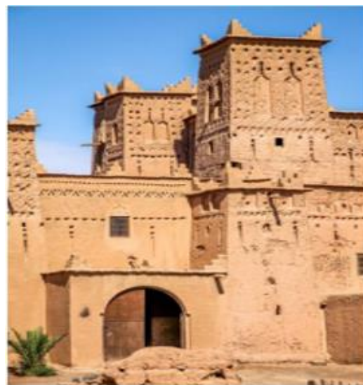
FIGURE 27 : MAISON FAMILIALE EN COURS DE RESTAURATION
