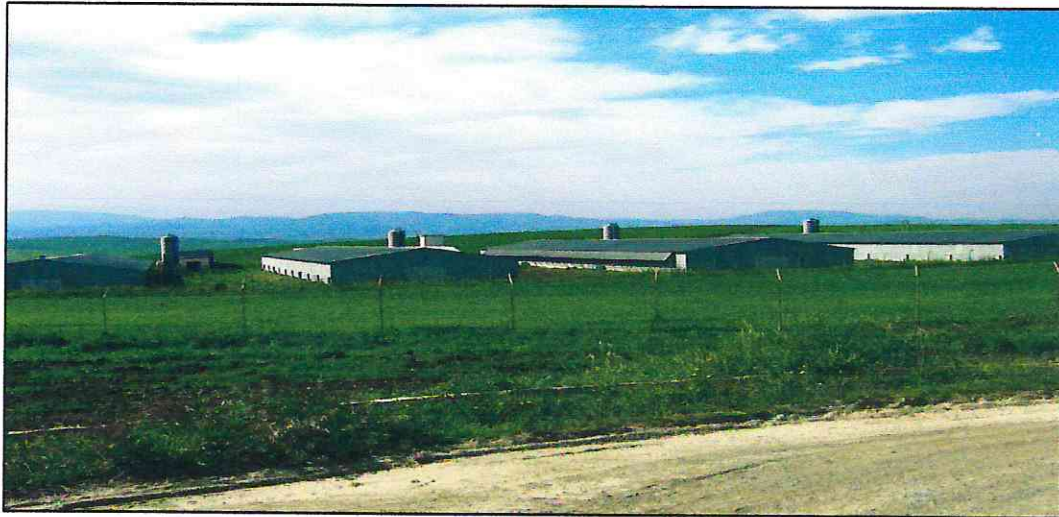
Photo N° 16 : Les bâtiments d'élevages
