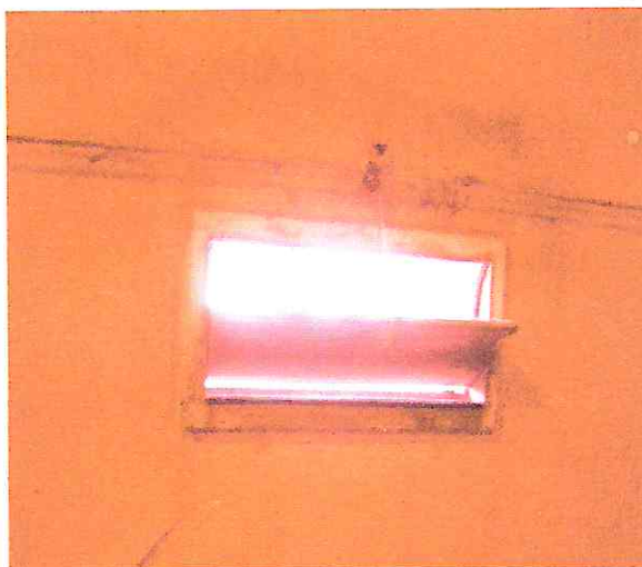
Figure 2: Ventilation statique (ouverture) (Guide Hubbard, 2005)
