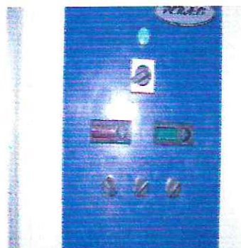
Photo 4: Tableau électronique où se fait l'affichage et le réglage de la température et l'hygrométrie
