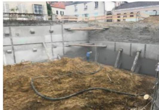
Figure 4.5 : Voiles en béton armé. Source : [www.ecobatis-travaux.fr](http://www.ecobatis-travaux.fr)
