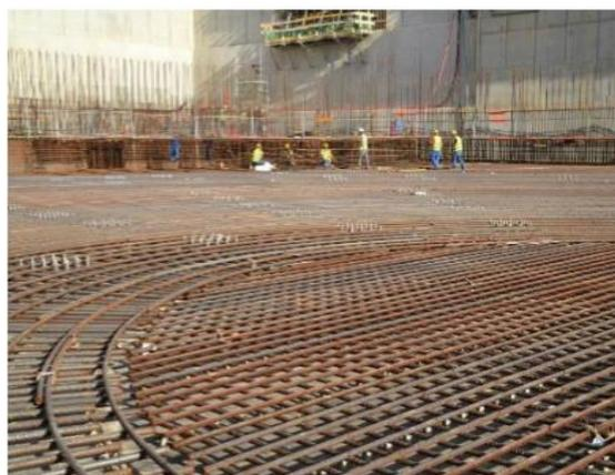
Figure 4.2 : Fondation en radier Source : [www.iter.org](http://www.iter.org)
