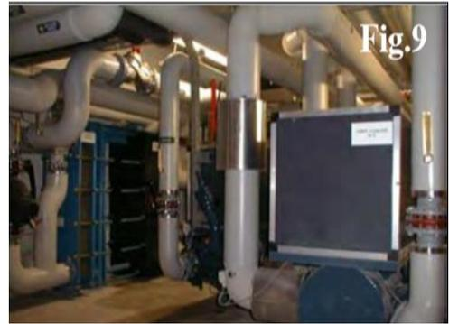
Figure 4.53 : La régulation thermique de l'aquarium assuré par une pompe de chaleur
