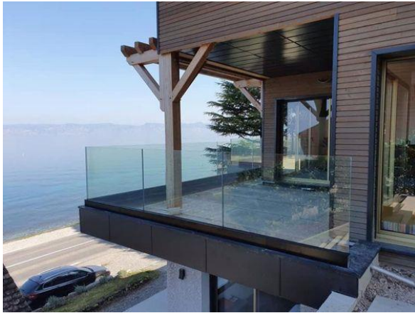
Figure 25: garde-corps en verre
