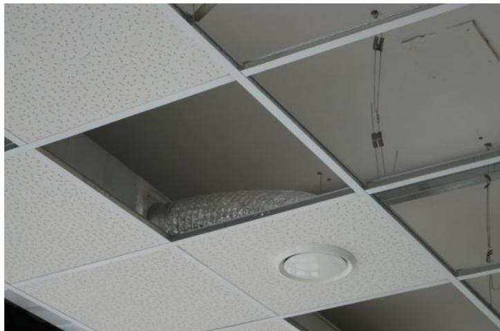
Figure III.61 : Faux plafond. Source : <https://www.guidebatimentdurable.brussels/fr/elements-de-faux-plafonds.html?IDC=7002>
