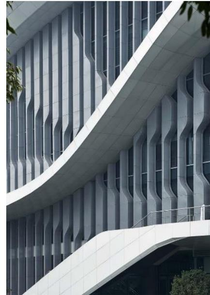
Figure V.59: Dispositif d'ombrage en lames en feuilles d'aluminium. Source : <https://www.archdaily.com/926218/zhejiang-huanglong-aquatics-center-csadi>
