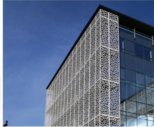
Figure III.75 : Brise soleil en tôle perforée. Source : <https://flashmetal.fr/facade-perforee/>
