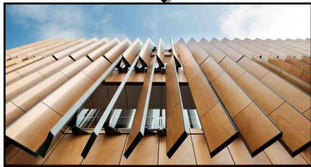
Figure 38: Brise soleil orientable à l'extérieur de maison (« Les systèmes brise soleil» 2015)
