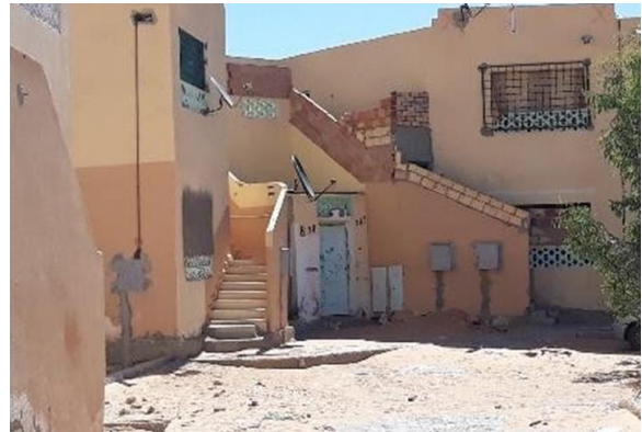
Figure 45: Murs construits ou élevés cachant les accès aux logements 2019 Source : MEMOIRE DE MASTER II Habitat Groupé à Ouargla, essai de reconstruction
