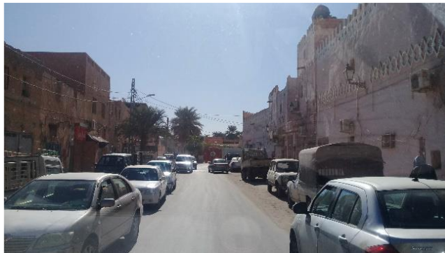
Figure80 : VOIE MECANIQUE EXTERIEUR DU KSAR Source : MEMOIRE DE MASTER II Essai de Reconstitution du Patrimoine Habitat au ksar de Ouargla
