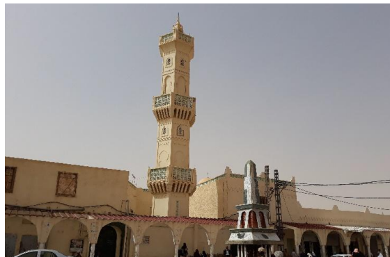
Figure73 : La mosquée de Sidi Baafou à l'état actuel
