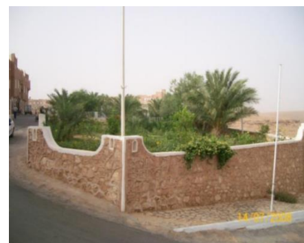
Figure 21: L'omniprésence de la végétation à Tafilelt malgré le climat hostile Source : C.-_CHABI_-DAHLI_- _Le_patrimoine_Un_referent_pour_le_renouvellement_urbain
