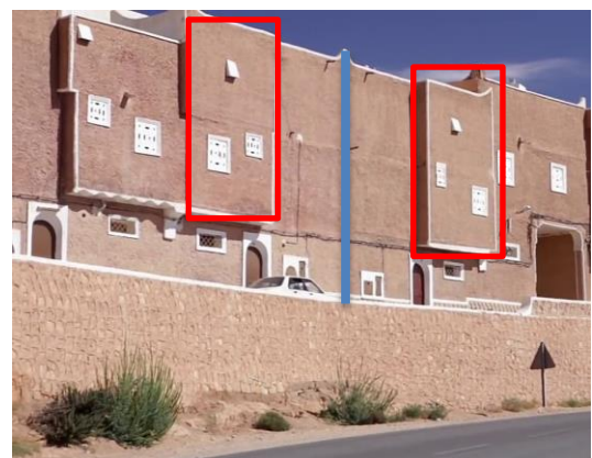
Figure 25: La symétrie dans les façades. Source : www.Tafilelt.com Traitée par les auteurs
