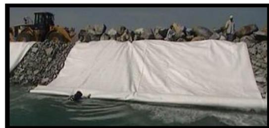
Figure 122 : phase de géotextile.
