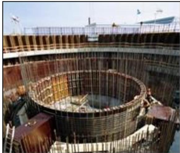
Figure 99 : ferrailage de noyau central.
