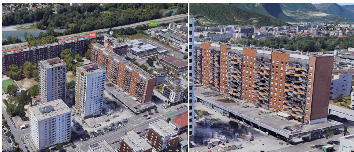
Figure 02 : La barre anathole (batiment a démolir) a Grenoble .
