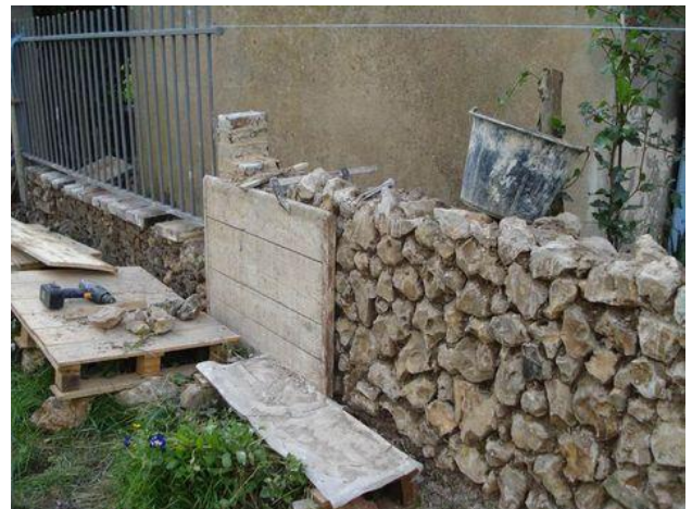
Figure66: Construction d'un mur en pierres et mortier de chaux/ source : www.pinterest.com/pin/79657487144029228/
