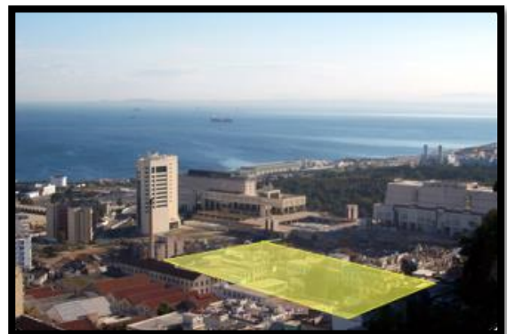
Figure 42: Situation de site d'intervention/ source: pris par l'auteur.
