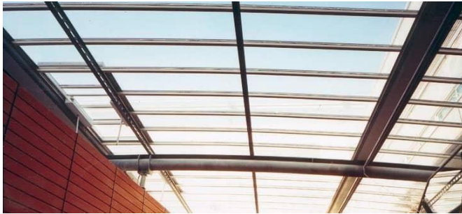
Figure 87: éclairage zénithal/source : www.hellopro.fr
