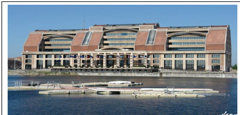
Figure 35 : Hôtel de la communauté, dunkerque, France source : http://compiegnephotos.canalblog.com
