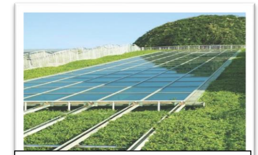
Figure 67 : panneau solaire, source : mémoire fin d'étude
