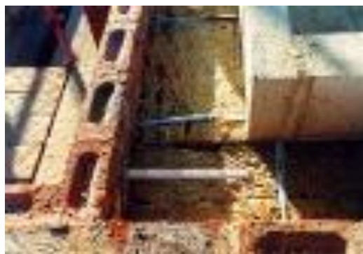
Figure 18 : Matériaux à grande massethermique, source : http://www.lausanne.ch/lausanne-en-bref/lausanne
