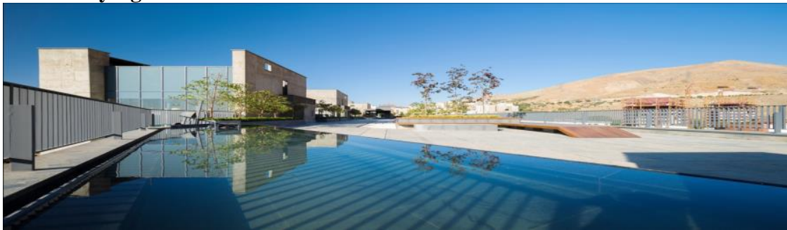
Figure 36 : toiture terrasse .Source : archdaily
