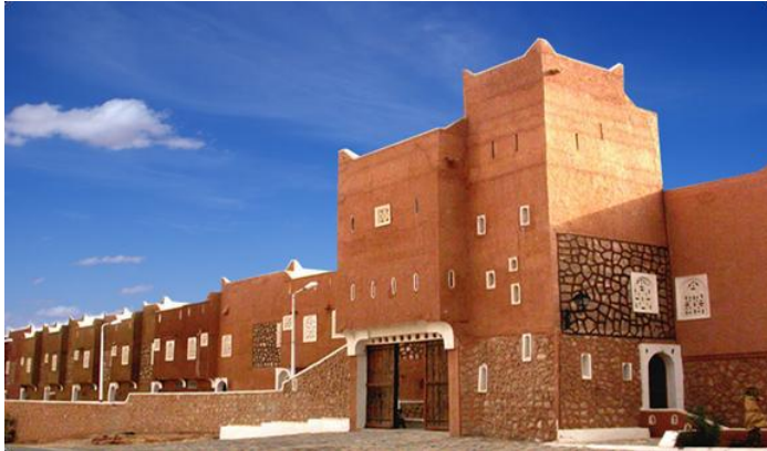
Figure 43 : façades Tafilalet source : http://issuu.com/site
