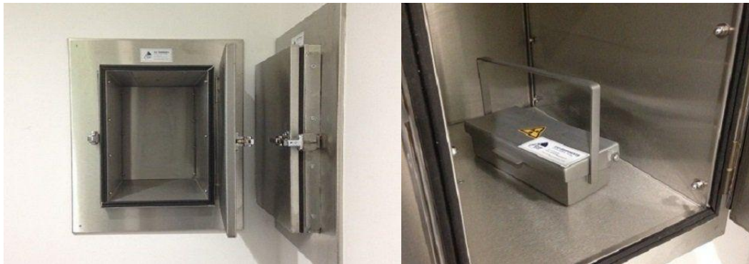
Figure 26 : Guichet transmural de transfert des doses radiopharmaceutiques (face intérieur et extérieur). (130)
