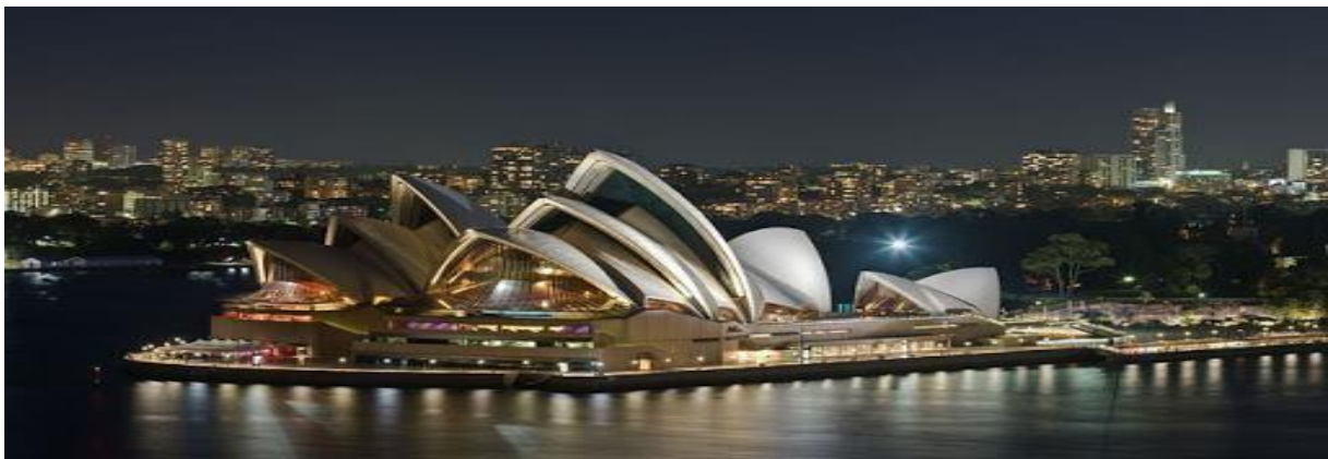
Figure 5: L'opéra de Sydney (Australie) sur l'ancien port, un monument architectural d'identité symbolique et de revalorisation du front d'eau de la ville. / Source : oceanien.com
