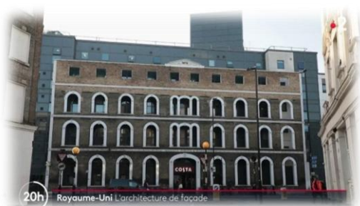
Fig.01 : Exemple de façadisme en plein centre de Londres Source : Google image
