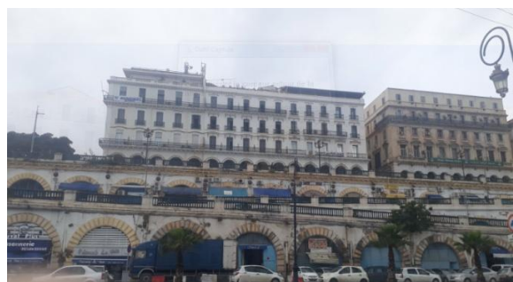
Fig.39 : Les immeubles sur le Boulevard Cheguevara Source : Prise par auteur
