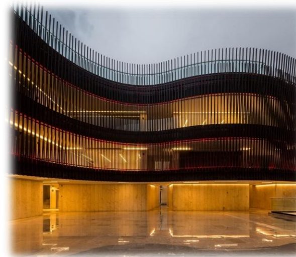
Fig.15 : façade de la cours intérieure de palais de la musique mexicaine . Source : /palace-for-mexican-music-alejandro-médina-
