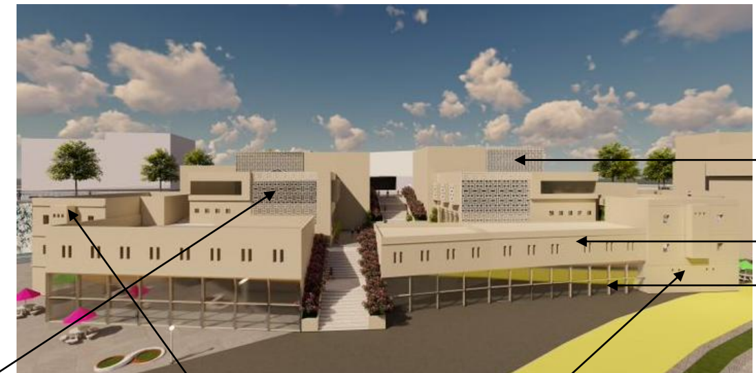
Fig.84 : Façade est Source : l'auteur
