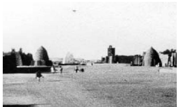
Figure 73 : Photo des deux cheminées de foggaras formant la nouvelle porte de Timimoune. Source : Cap terre.
