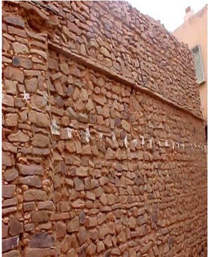
Figure 19 : Construction en pierre à Kenadsa
