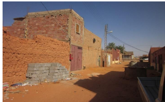
Figure 76: Photo d'une maison en parpaing au ksar de Timimoune. Source : Prise par l'auteur.
