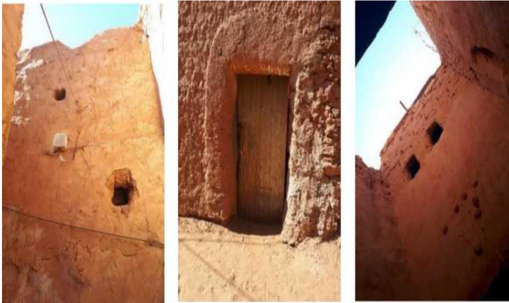
Figure 82 : Photo montrant les ouvertures des facades du ksar E. Texture : Source : Auteur2020
