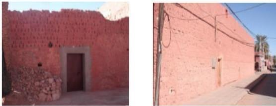
Figure 60 : Les façades d'ancienne construction de village. / Source : Bouhalla.
