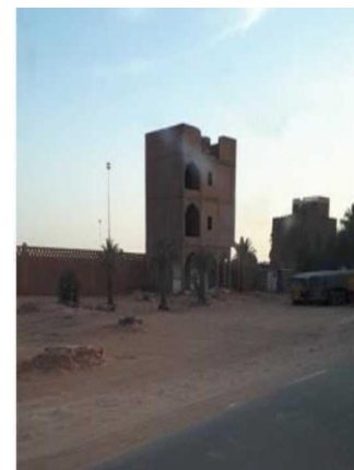
Figure 96 : Les facades du tissu actuel. Source : Auteur 2020
