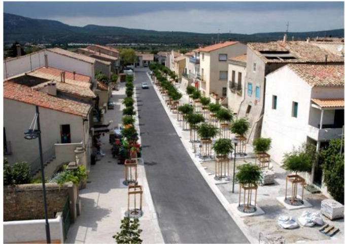
Figure 27 : Photo du boulevard des Acquières au centre Bourg de Vic-la-Gardiole- France
