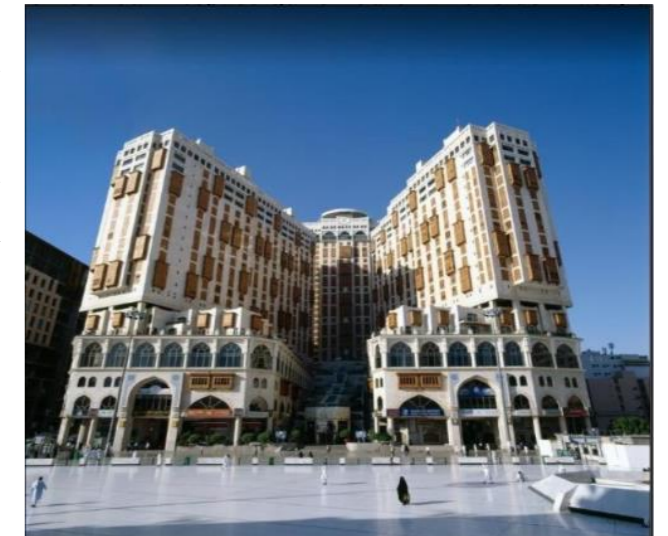
Figure 106 : Photo du CMF de la Mecque. / Source : Galerie de Google map.
