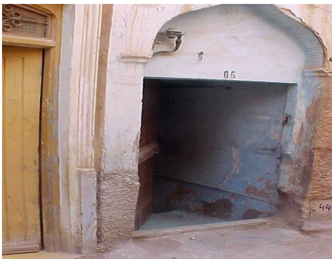
Figure 18 : Traitement de la porte d'entrée d'une maison mozabite à Ghardaïa
