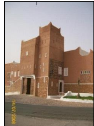
Figure 13: entrée urbaine et tour bureau
