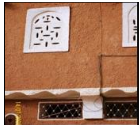
Figure 25 : La forme de protection solaire de Tafilelt. Texture rugueuse Source : http://tafilelt.com/
