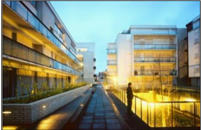
Figure 10 : vue de l'extérieur Source : https://www.europanf/realisation/reims-rue-du-mont-
