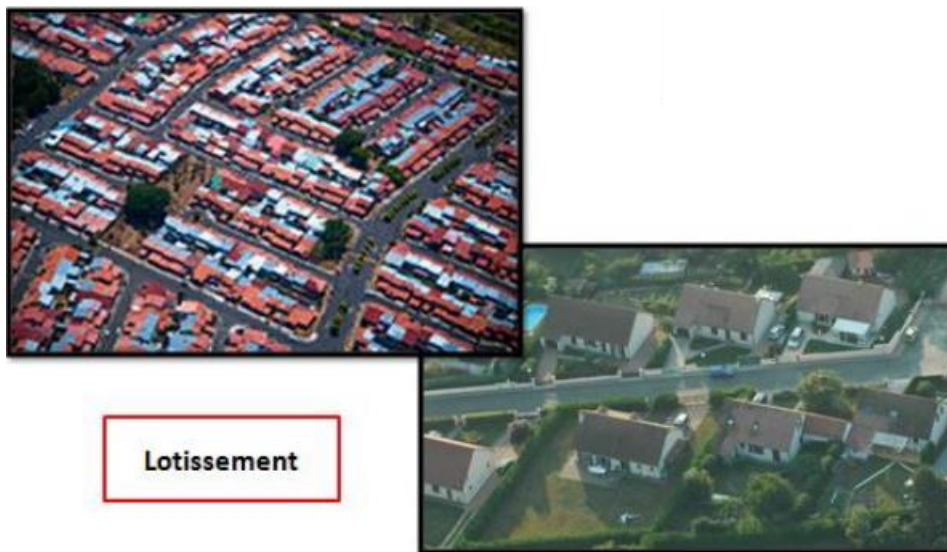
Figure 7 : vue aérien de lotissement
