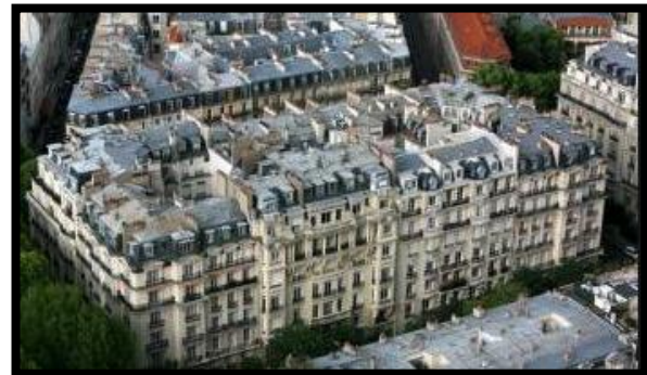
Figure 5 Bloc d'immeuble à Paris (Haussmannien)
