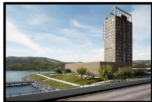
Figure 6 Bâtiment tour - Mjøn Norvège
