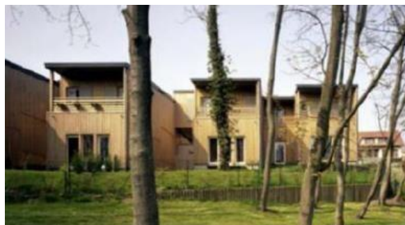
Figure 44 :Maisons en bande à Ormesson, France. Source : Mialet Frédéric, Le renouveau de l'habitat intermédiaire, PUCA collection Recherche, coédition CERTU/PUCA, 2000.
