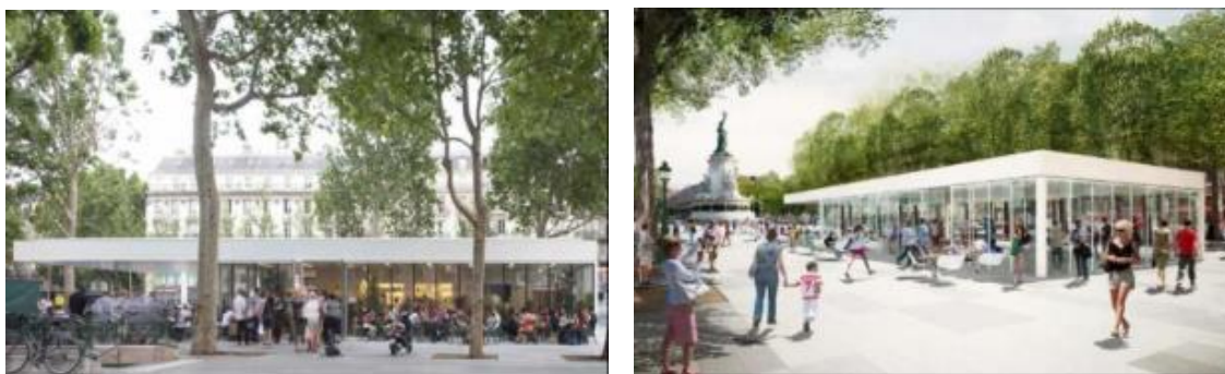
Figure 38 : Le Pavillon Monde & Médias de place.
