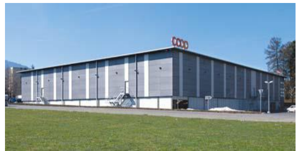
Figure34 : Façade lisse, ventilée avec granit et tôle / Source : centre commercial Coop “LE CÂRO”, BULLE–Fr., ArchitectureConstruction.ch Ouvrage no 1212
