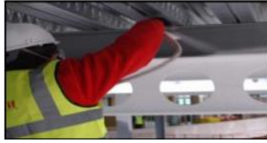
Figure N°= 79 : protection par flochage
