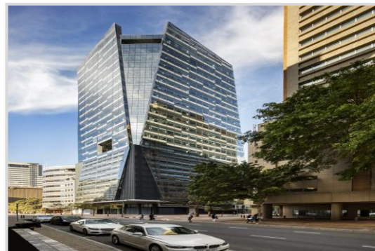
Figure N°= 4: La tour de bureaux en Afrique du Sud
