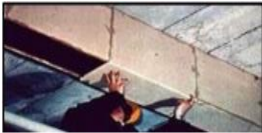
Figure N°= 80 : protection par plaques
