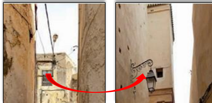
Figure 19 Eclairage public dans la Medina Meknès Source : conception et aménagement des espaces publics et circuit touristique dans les Médinas
