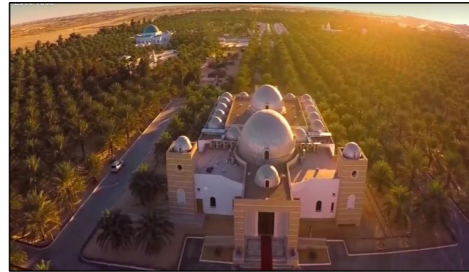
Figure 112 : vue sur La gazelle d'or Source : http://dia.algerie.com
