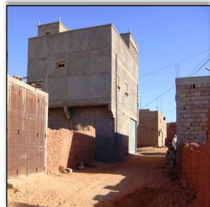
Figure 39 : Façade de nouvelle construction. Surce : memoir 2020
