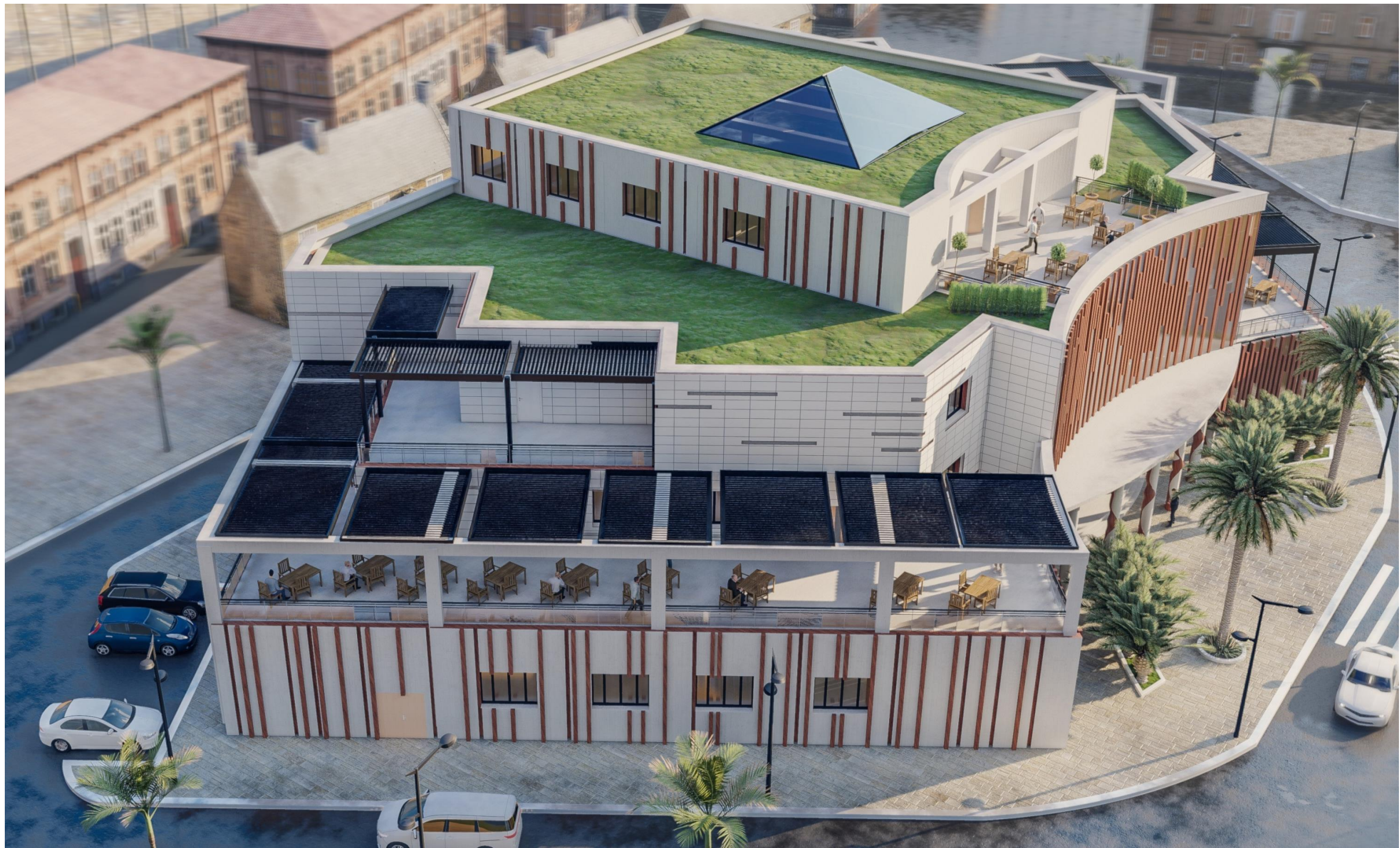
Vue sur la façade Sud
