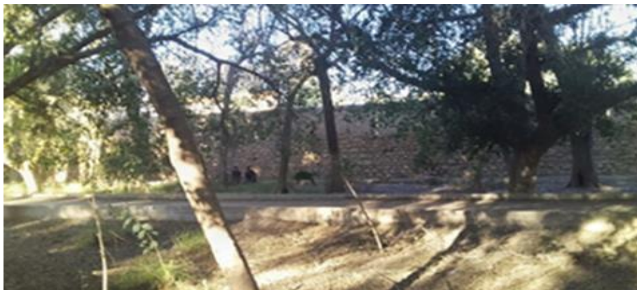
Figure 55: les débris de l'ancien fort saint germain
