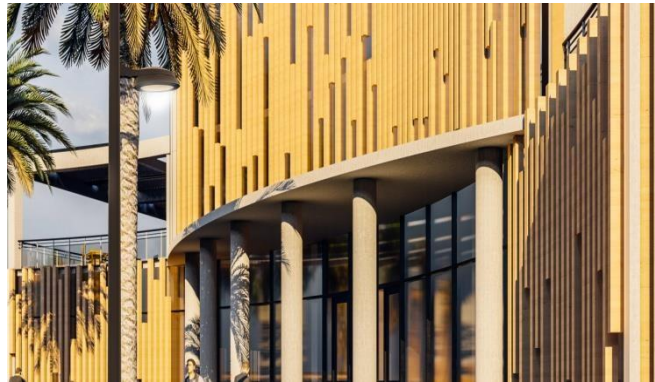
Figure 87: Traitement de la façade du CSC Source : Auteurs
