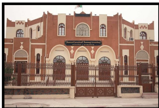
Figure IV. 52: La mairie de la ville de Tamanrasset Source : https://fr.wikipedia.org/wiki/Tamanrasset
