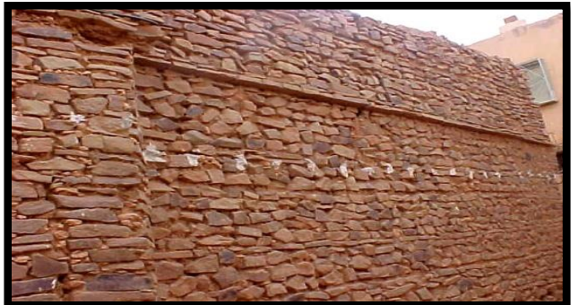
Figure I. 22: Mur d'un Ksar en Pierre
