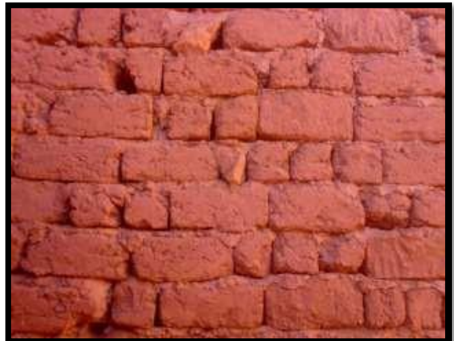
Figure III.54 : murs de brique d'adobe à Timimoune ;source :Capterre
