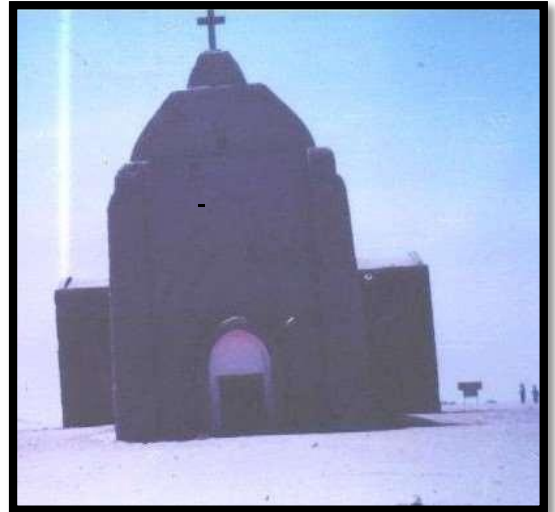
Figure III.22 : Photo de l'église Source : Cap terre.
