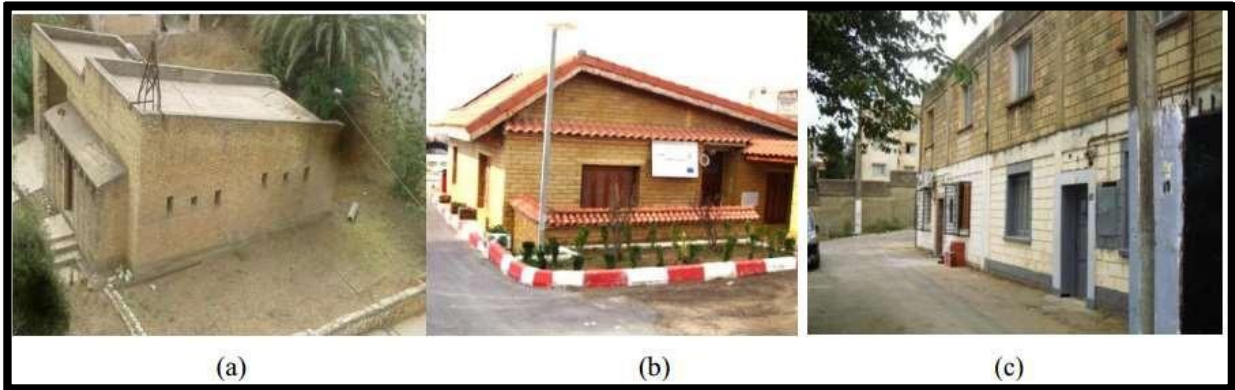
Figure II.17 : Prototypes de logements en BTS dans le Nord, a) Prototype bioclimatique de Souidania, b) prototype Medenec, c) Logements de Beni-Messous
