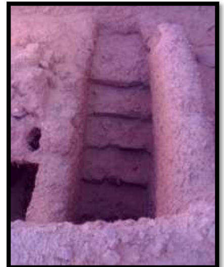
Figure III.56 : Escalier en terre; source : capterre
