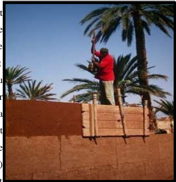
Figure II.6 : Fabrication du pisé traditionnel dans la Vallée du Draa, au Maroc. Source: Mimó 2014
