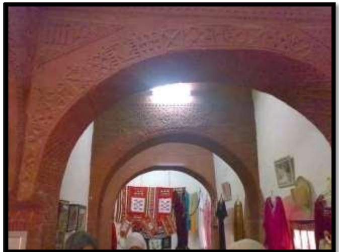
Figure III.62 : arc à Timimoune ; source : Capterre
