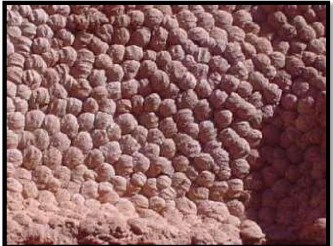
Figure III.61 : Enduit extérieur d'un mur à Timimoune ; source : Capterre
