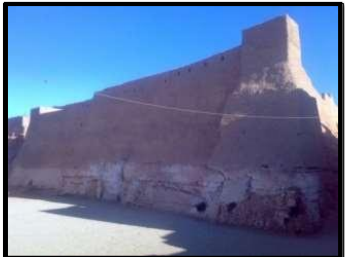
Figure III.47: Akham Sidi Brahim, construit sur une roche de Tafza ; source : Capterre
