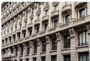
bâtiment monumental situé sur la Via Laietana, Barcelone
