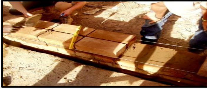
Figure 61 : construction d'un mur en BTCS
