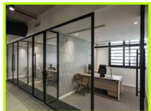
Figure 55: Cloisons vitrées Source : auteur, 2019
