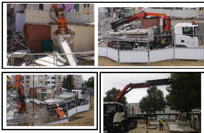
Figure 23: réemploi de béton issu d'une démolition, en façade légère. Chantier mixte traditionnel et d'apprentissage (avec la Régie de Quartier de Stains), Clos Saint Lazare. (Source: L'ADEME)
