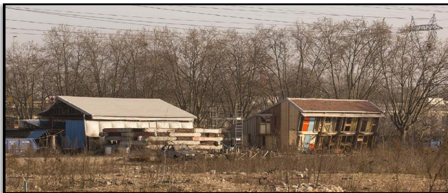
Figure 25: un équipement de chantier dédié au réemploi sur la Zac de l'éco-quartier Fluvial de L'île-Saint-Denis: ACTLAB. (Source: L'ADEME)
