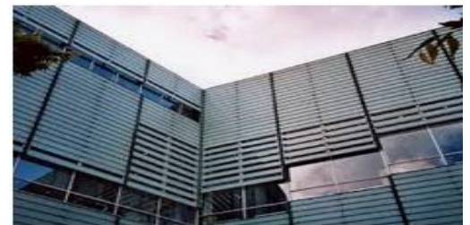
Figure56: la façade arrière de la bibliothèque (Source: https://www.chezlefilrouge.com )
