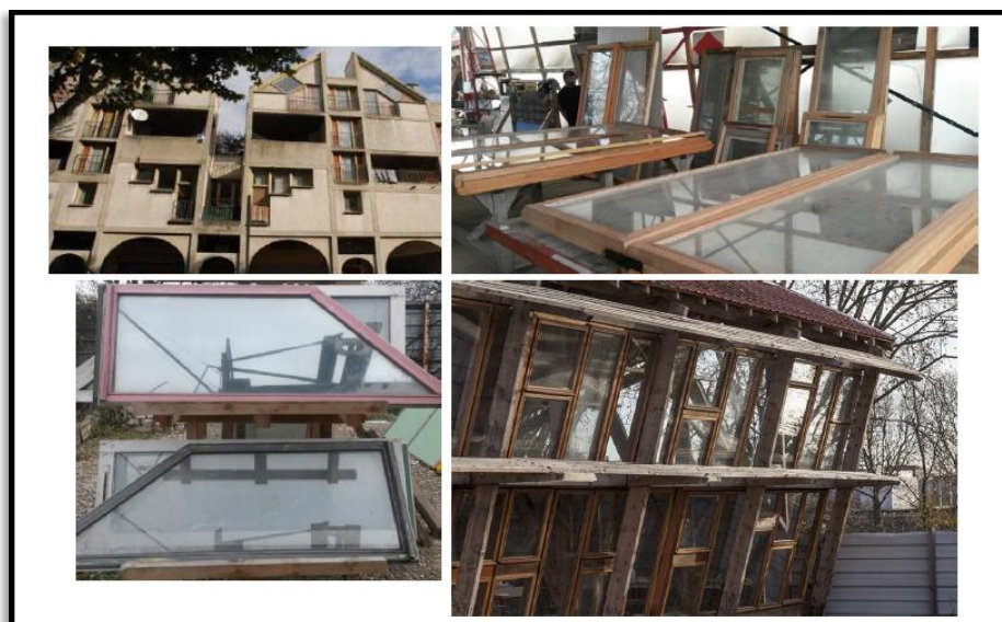
Figure 18: réemploi de fenêtres bois issues d'une réhabilitation de logements sociaux en façade légère. Chantier démonstrateur à L'île-Saint-Denis, Actlab (Source: l'ADEME )
