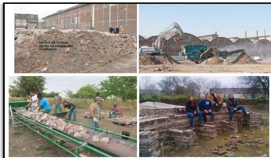
Figure 21: réemploi de briques issues d'une démolition en maçonnerie paysagère. Chantier école avec Halage à Stains, la Ferme des possibles.(Source: ADEME)
