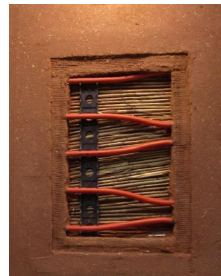
Figure 42 : Mur chauffant avec enduit de terre crue
