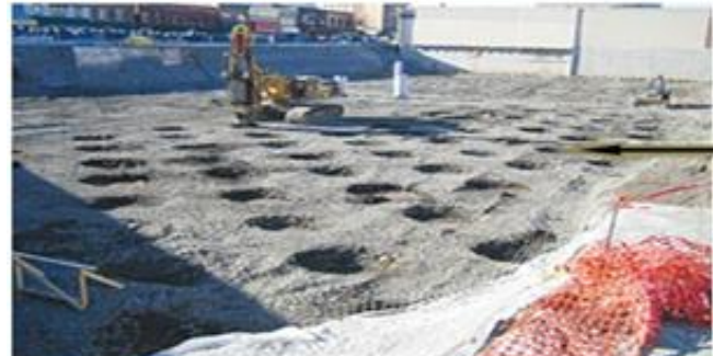
Figure 164 : Chantier de compactage
