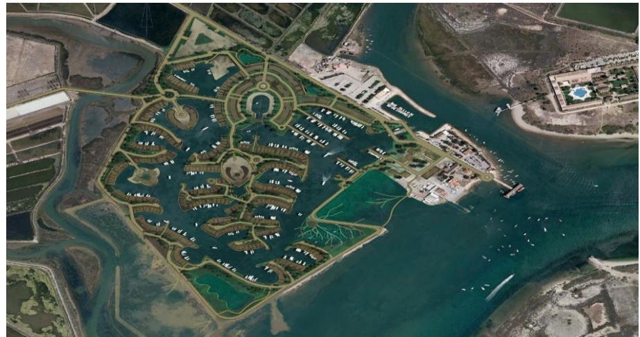
Figure 24 : Vue sur les constructions flottantes du port
