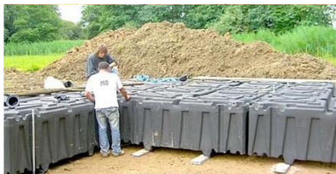
Figure 43 : Assemblage des coffrages
