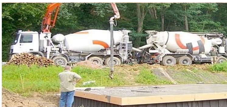
Figure 44 : Dalle béton traditionnelle
