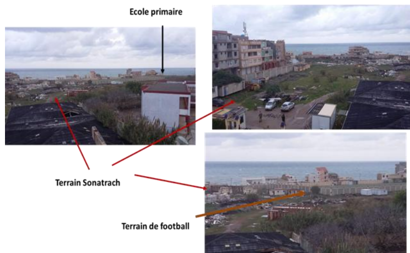
Figure 119 : Vue à partir du site
