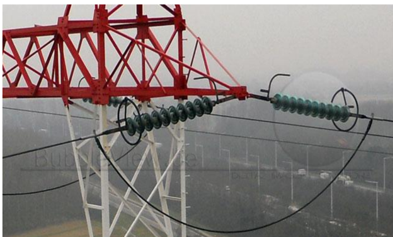
Figure 1.8: Chaînes d'isolateurs
