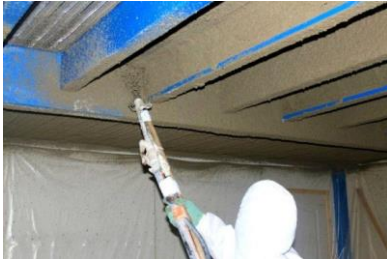
Figure III.46 : Finition du flocage métallique
