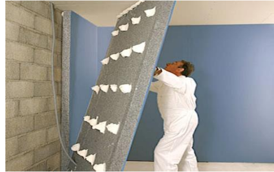
Figure IV.26 : Mise en œuvre BA13 hydrofuge
