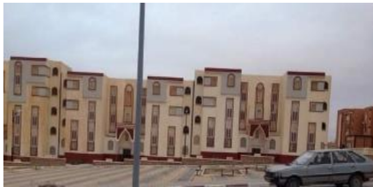
L'habitat collectif source auteur
