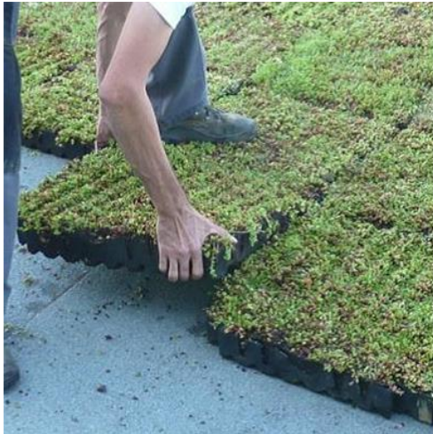
Figure II.12 : Végétalisation en bac pré-cultivé Figure II.13 : Végétalisation extensive
