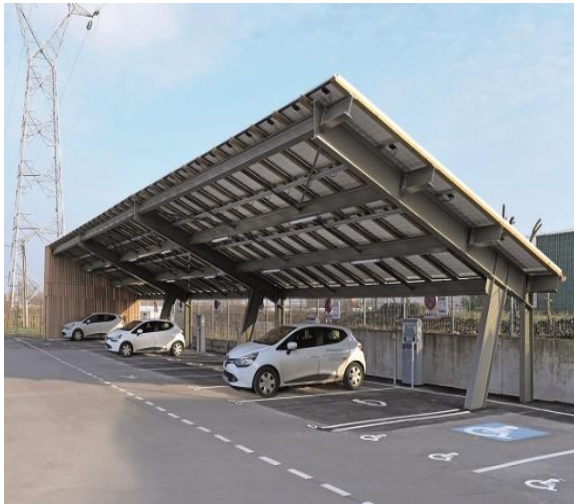
Figure IV.13 : Vue sur Une ombrière photovoltaïque.
